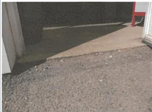
Les seuils doivent être chanfreinés de façon à permettre un passage plus aisé des roues d'un fauteuil roulant.
